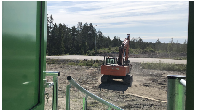
Byggstart för nya växthuset i Härnösand.
