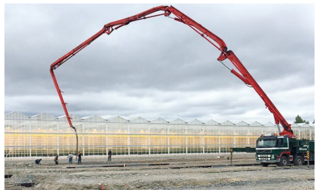
Här gjuts betongplattan till nya växthuset.
